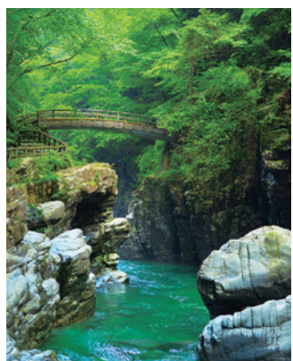
② 関門遊歩道から見た空船橋
