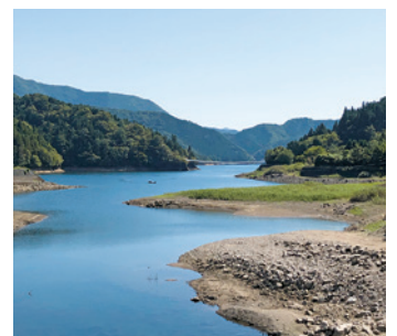
④ 面河ダム公園は絶好の休憩スポット。四季彩橋も見られます
